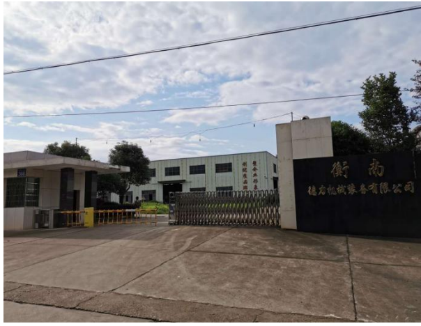
项目厂区大门
